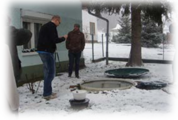
εγκαταστάσεις επεξεργασίας λυμάτων
